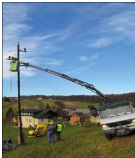
Sliki 7a in b: Prikaz preventivnega vzdrževanja SN-omrežja
