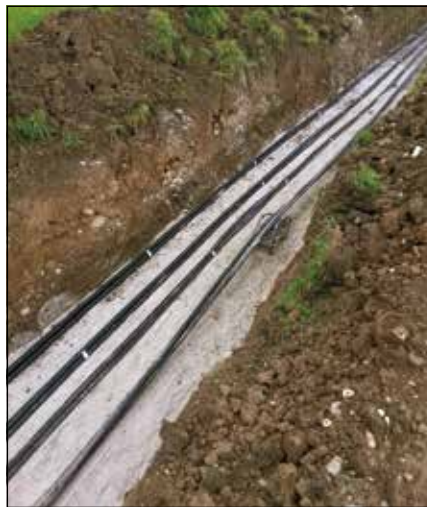
Slika 2: Izgradnja novih srednjenapetostnih vodov
