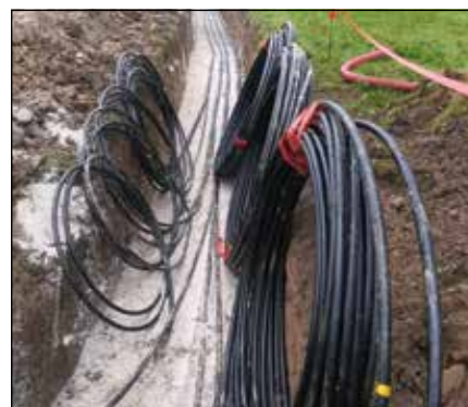
Slika 5: Izgradnja srednjenapetostnega omrežja
