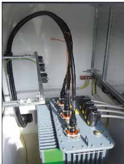
Sliki 11a in b: Rekonstrukcija srednje- in niskonapetostnega dela transformatorske postaje
